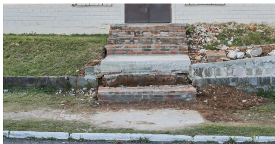
FOTO 2: Escada de acesso à sede.
